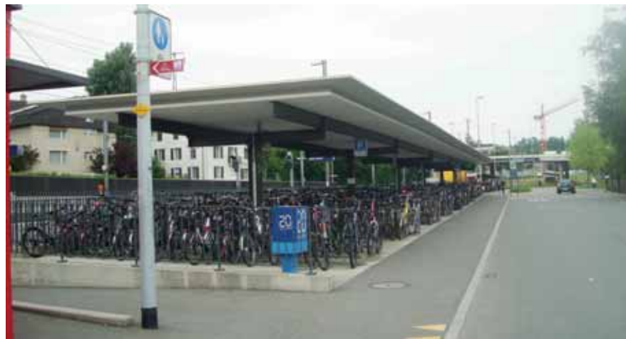
Abb. 14 Veloabstellanlage auf der Ostseite des Bahnhofes bei der PU Nord.
