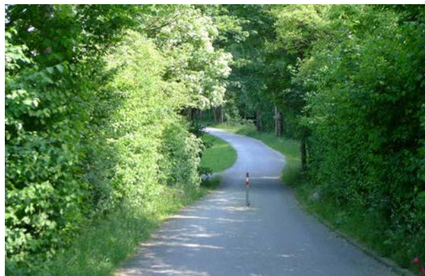
Ungenügende Erkennbarkeit des Pfostens
